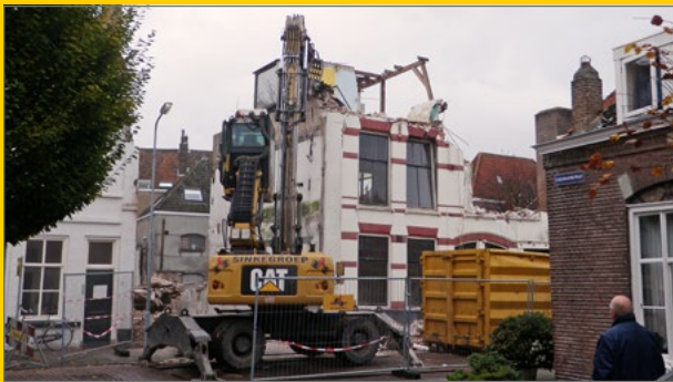
Sloop woonhuis binnenstad Middelburg.
