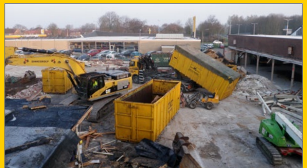
Sloop voormalig industrieterrein Welgelegen Tholen.
